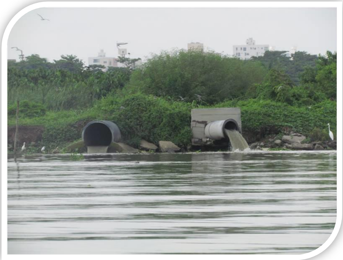
Vertimiento de aguas residuales al río Magdalena, Atlántico. Foto: Paola Obando
